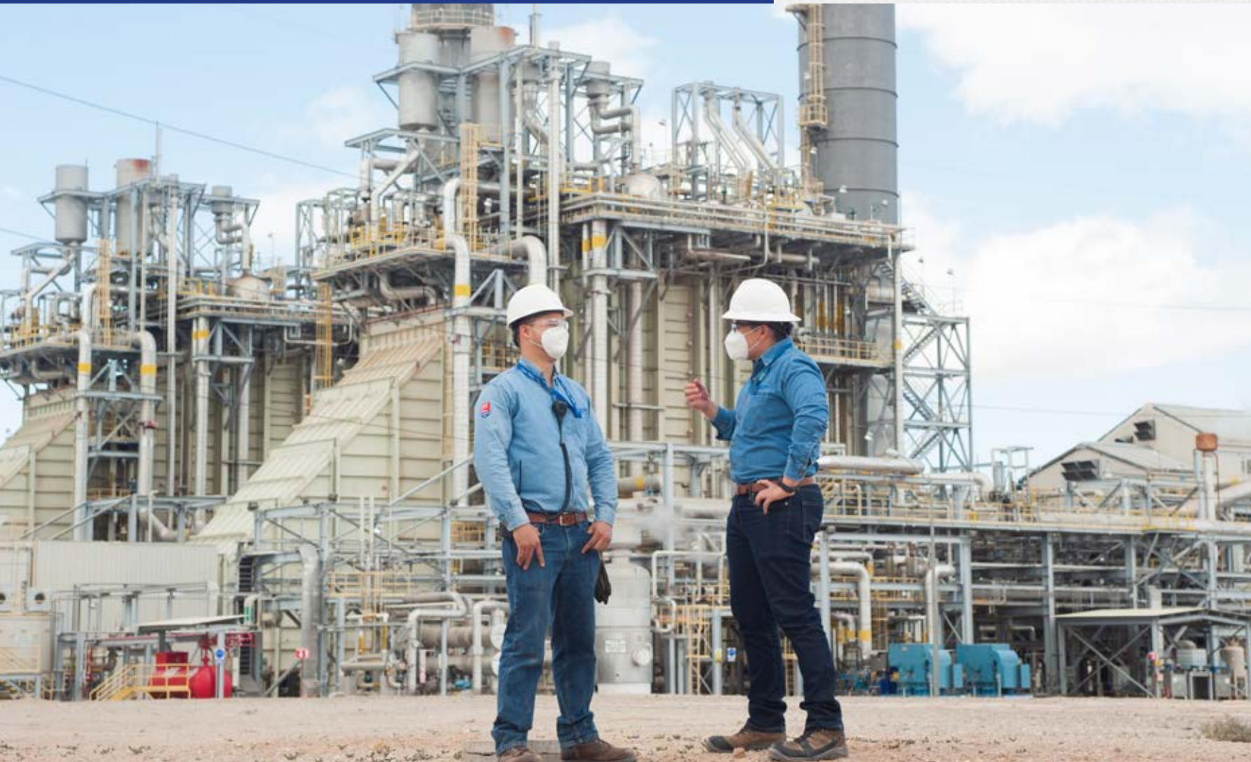
Termoeléctrica de Mexicali
